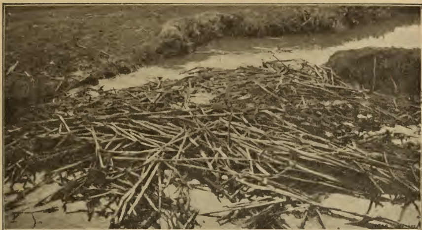
FIG. 51. — Entre Tobhar et Medinet el Fayoum, simple petit barrage de dérivation en tiges de cannes.
